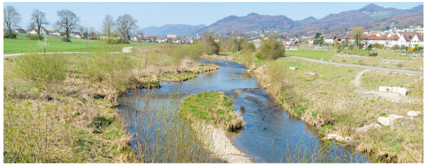
Revitalisierung (2015) «Dünnernufer Altmatten», Wangen b.O.
