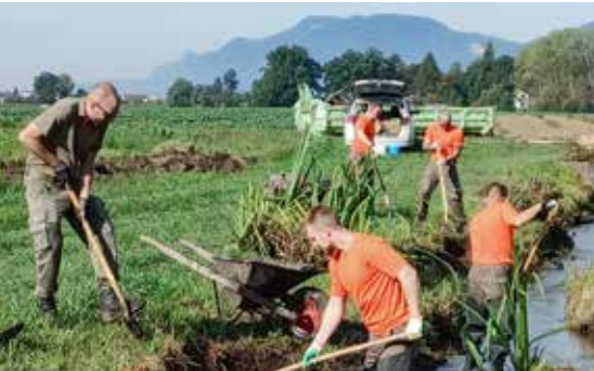
▲ Zivilschutztruppe beim Feinschliff der ausgebaggerten Nischen.
